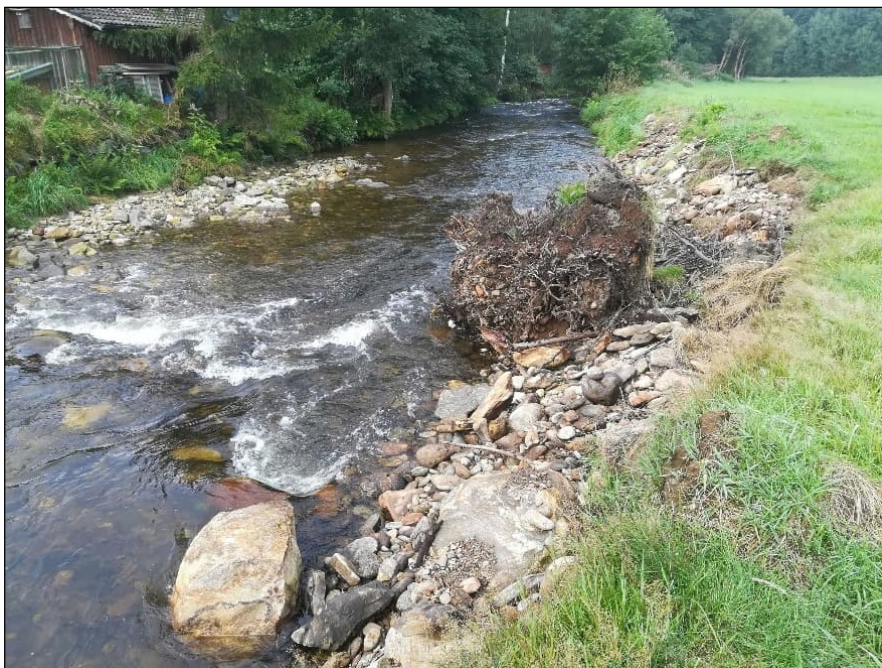
Rothbach bei Kronhammer. Sohlschwelle.
