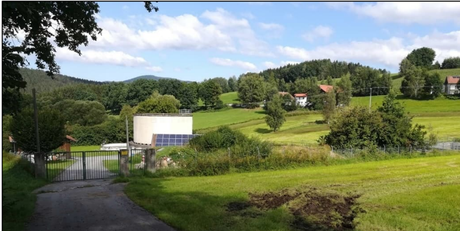
Kläranlage bei Roppendorf
