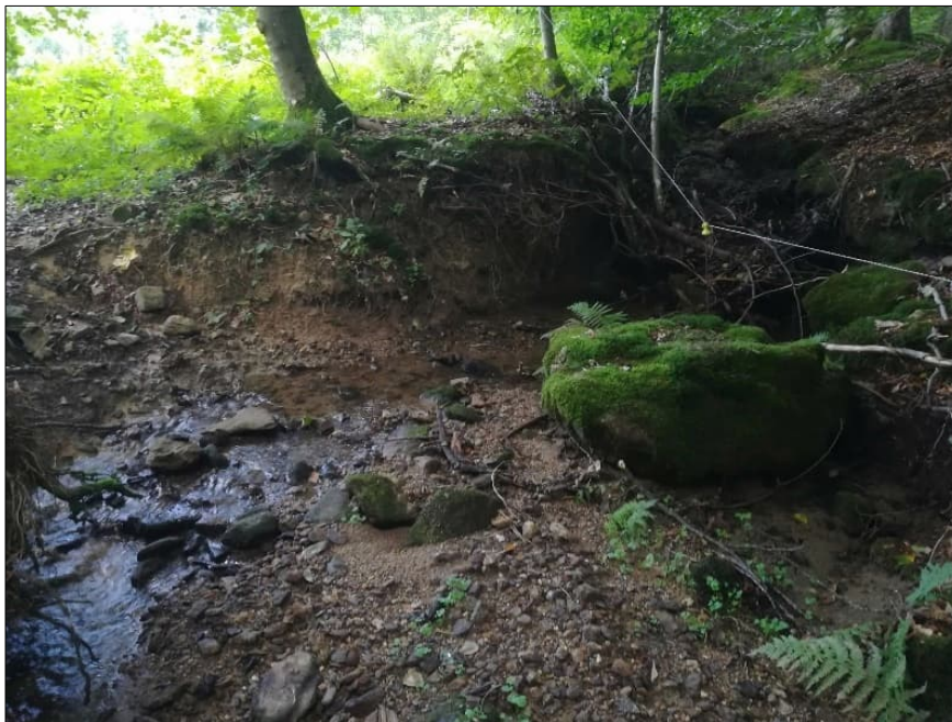
Katzenbach westlich der gleichnamigen Ortschaft
