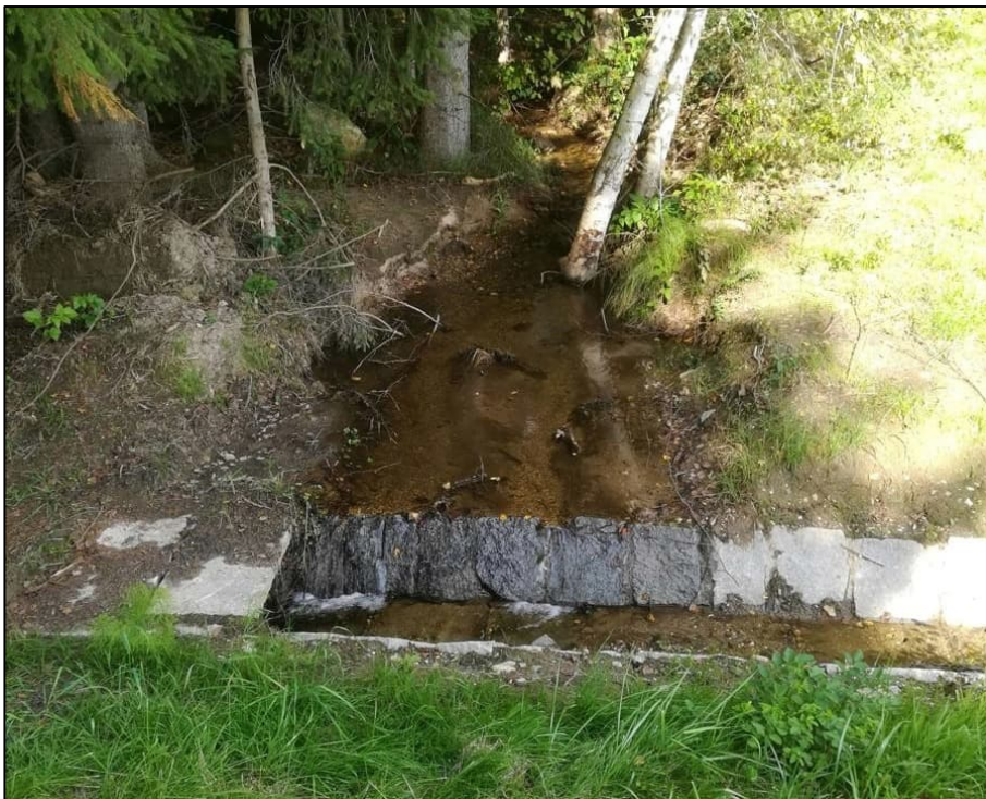
Zulauf des Steffelsbaches nördlich von Jägerhaus mit Verbauungen
