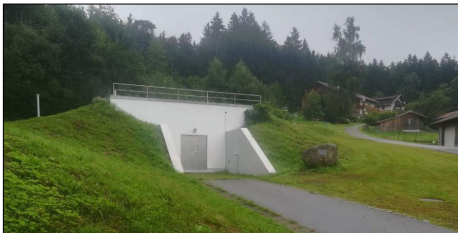
Hochbehälter am Plattenweg
