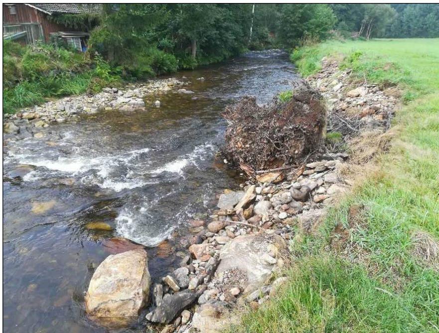
Rothbach bei Kronhammer. Sohlschwelle.
