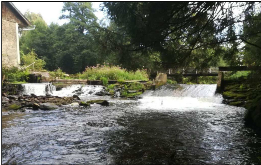
Rothbach bei Böbrachmühle. Wehranlage nicht durchgängig.
