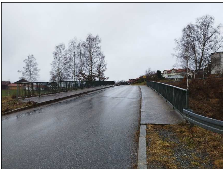
Blick von Süden auf die Brücke über die St 2136 und die Zufahrt aus Böbrach.
